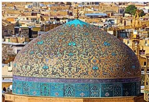
تصویر ۳- نمای کلی از پوشش بیرونی گنبد مسجد شیخ لطف‌الله با نقوش اسلیمی و کاشی‌های معرق (آبی فیروزه‌ای، زرد، سفید) در
